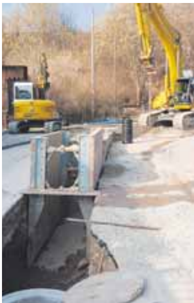
Viel Geld fließt heuer in den Kanal, hier die Baustelle in der Badgasse in Ebermergen.
