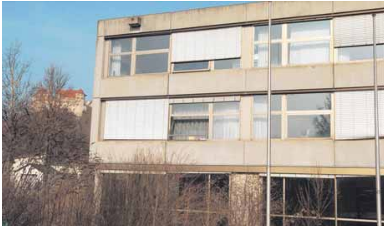
Die Volksschule in Harburg wird mit einem Kostenaufwand von 2,4 Millionen Euro energetisch saniert. Das Projekt taucht im städtischen Haushalt 2009 gar nicht auf, weil es extern finanziert wird. Fotos (7): Widemann
