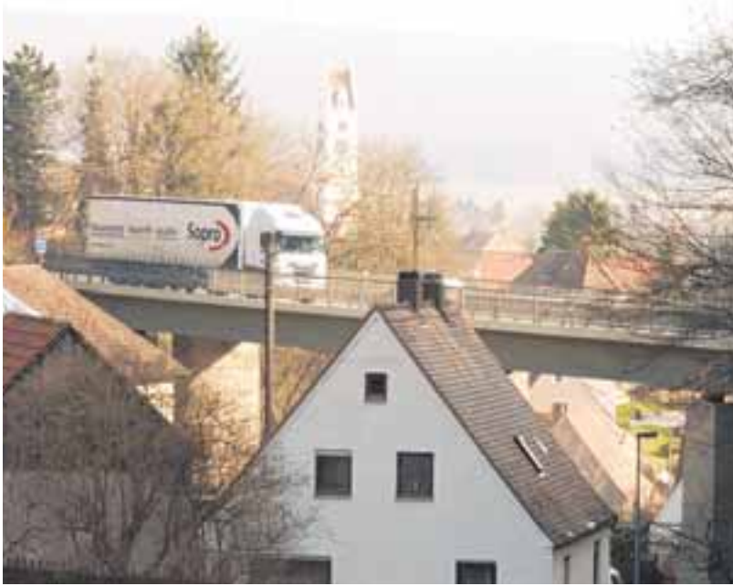
Nur wenige Meter von Wohnhäusern entfernt rollt der Verkehr auf Brücken durch Harburg. Viele Bürger klagen über zunehmenden Lärm.
